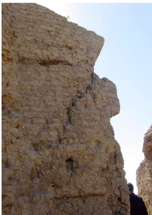
Fig. 4. Photo d'un départ de voûte nubienne de la deffufa occidentale à kerma (d'après Cl. Rilly).
