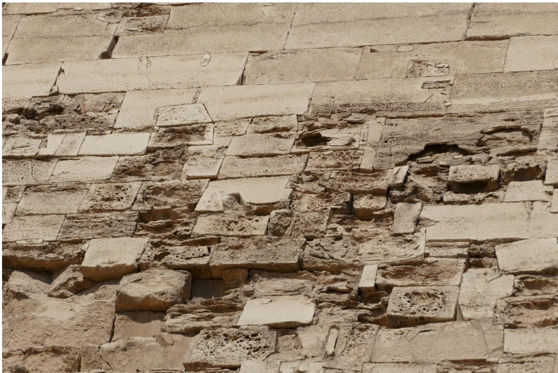
Pl. 8b. Réparations avec patches sur la face orientale de la pyramide rhomboïdale
