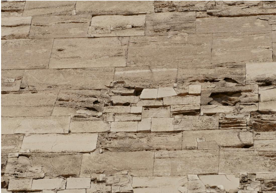
Pl. 8a. Réparations avec patches sur la face orientale de la pyramide rhomboïdale
