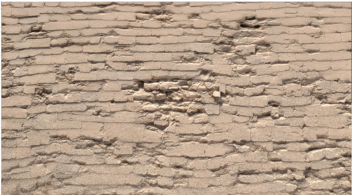
Pl. 6b. Assises en appareil irrégulier de la partie supérieure de la face nord de la pyramide rhomboïdale (© Label News).
