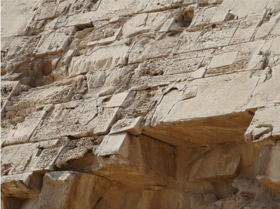
Pl. 7a. Réparation avec patches au pied de la face nord de la pyramide rhomboïdale (photo : Franck Monnier).
